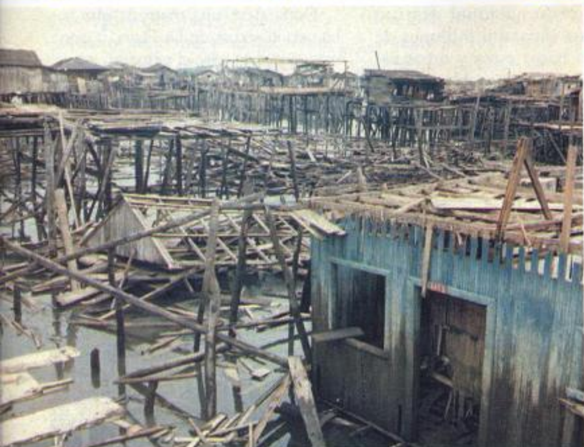
EL TERREMOTO DE 1979 marcó 7,9 en grados en la escala de Richter y dejó 38 muertos en Tumaco. Junto al de 1906 (8,4 grados) es uno de los sismos más fuertes que han ocurrido en Colombia.
