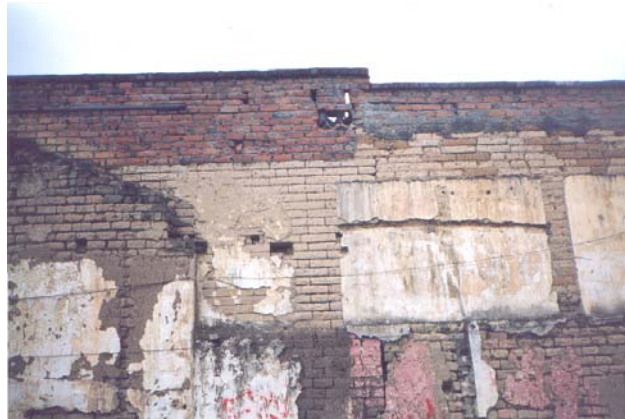
Figura 124. Mezcla de unidades de mampostería.
