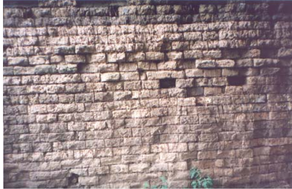
Figura 122. Detalle de un muro de adobe.
