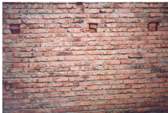
Figura 123. Muro construido en ladrillo unido con calicanto ó mortero pobre.
