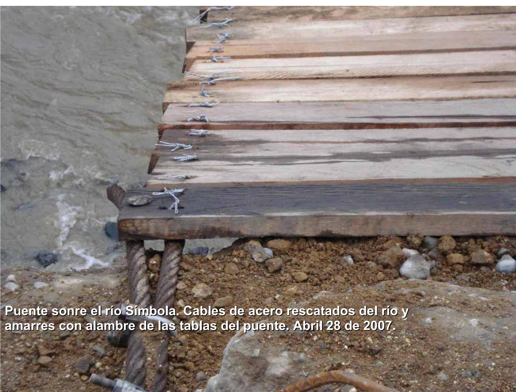
**Puente sobre el río Símbola. Cables de acero rescatados del río y amarres con alambre de las tablas del puente. Abril 28 de 2007.**
