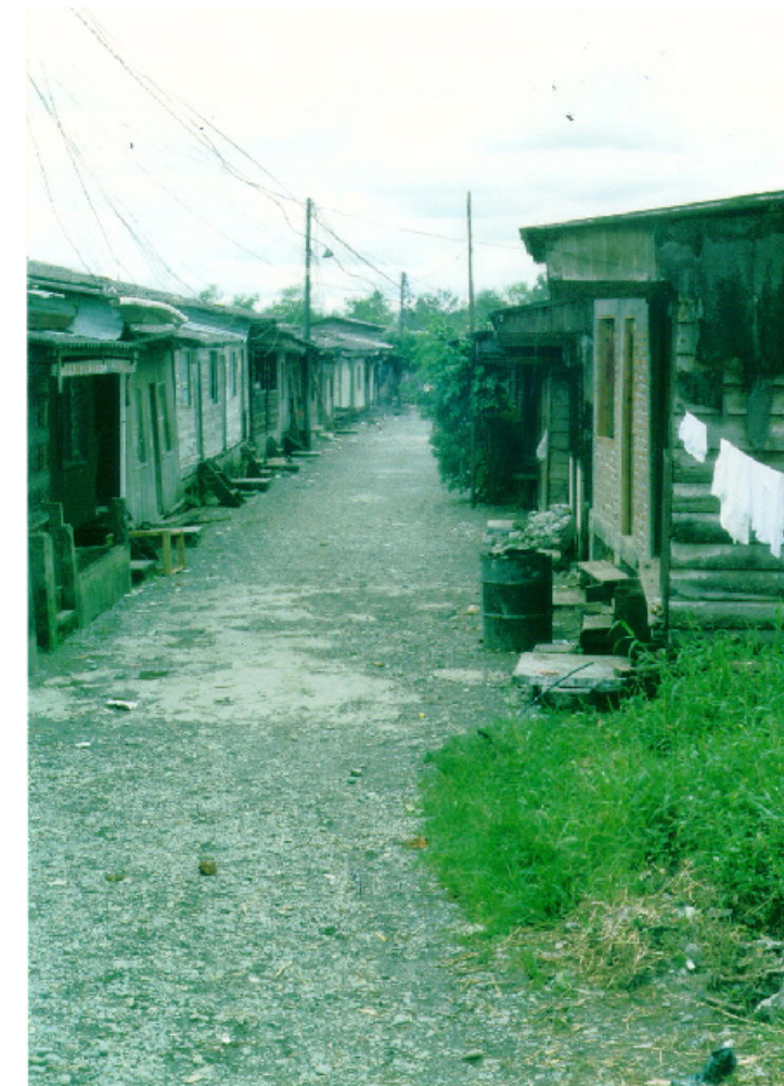
Calle consolidada (gravas) sobre relleno de basuras
