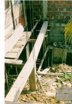
Viga amarrada a muro de contención, construido cerca a vía férrea
