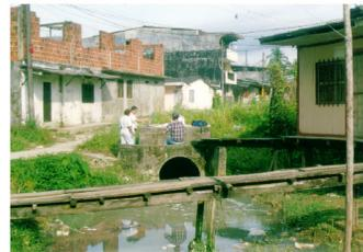
Mezcla de aguas residuales con aguas lluvias; obstrucción de canales con basura
