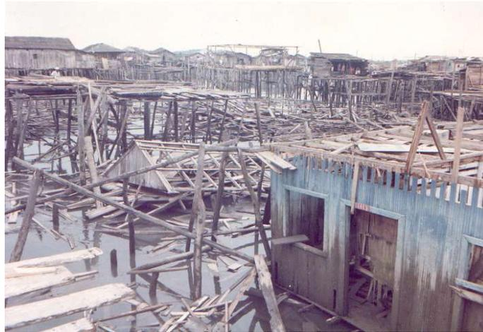
**Figura 12. Destrucción de vivienda palafítica durante el terremoto de 1979.**
