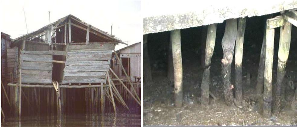
**Figura 7. Vivienda en madera deteriorada.**
