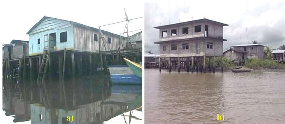
**Figura 19. Cambio de materiales flexibles por rígidos.
