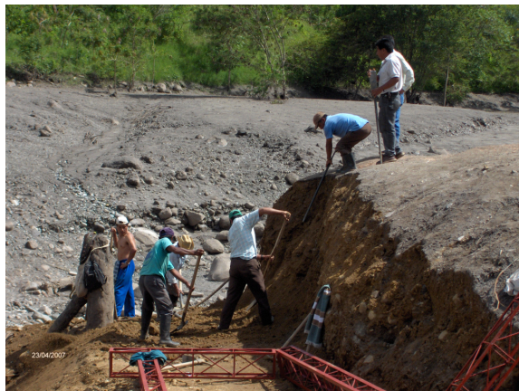
Dstrucción Puente Vehicular del Río Simbola Resguardo de Belalcázar. Reconstrucción comunitaria puente peatonal.
