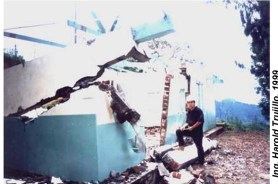
**Figura 27.** Colapso de una edificación por falta de confinamiento en el terremoto del 25 de enero de 1999 en el Eje Cafetero.
