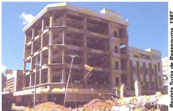
**Figura 29.** Edificio moderno de estructura aporticada.
