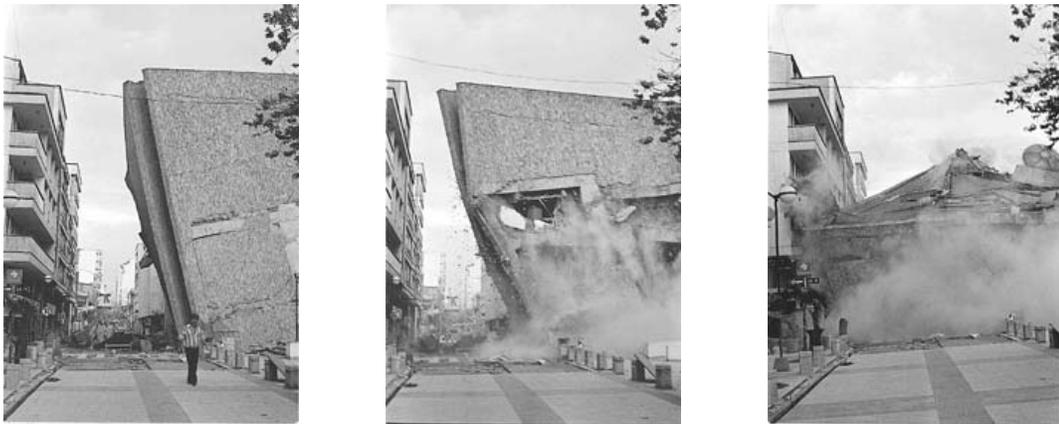
**Figura 51.** Colapso de un edificio moderna en Armenia, durante la replica de las 5:40 p.m el 25 de enero de 1999.
