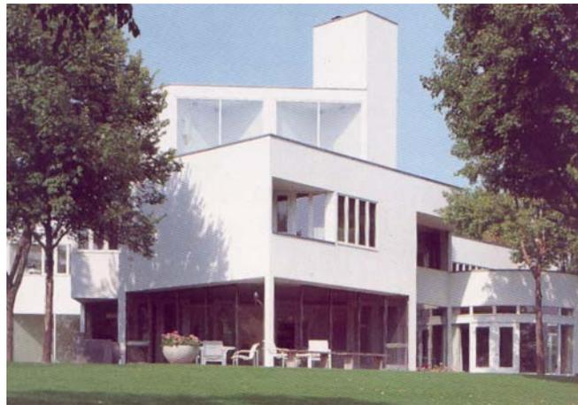
Figura 16. Edificación irregular en planta y altura.
