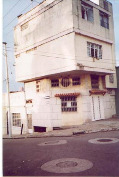
**Figura 12.** Edificación con irregularidad en altura.
