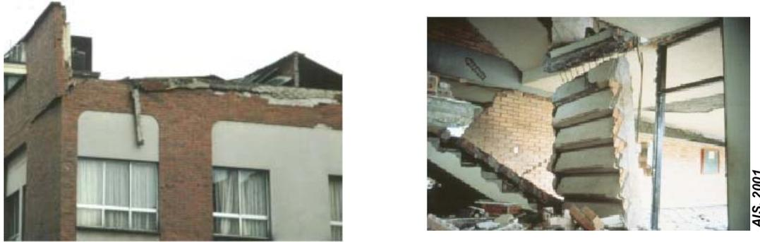
**Figura 30.** Falla en elementos estructurales mal conectados o diseñados.
