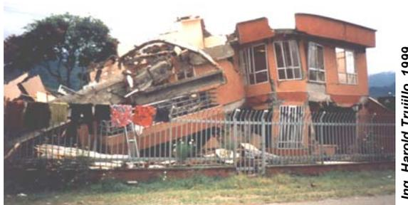
**Figura 26.** Colapso de una edificación por deficiencias en su estructuración
