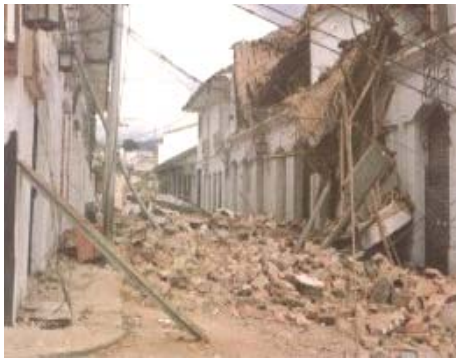
Figura 49. Viviendas de adobe afectadas por el terremoto del 31 de marzo de 1983 en Popayán.
