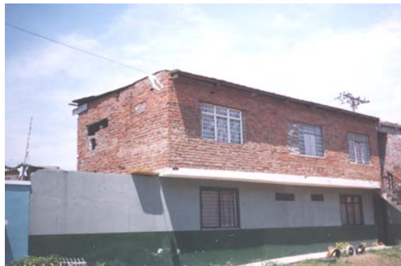
Figura 13. Edificación de tipo estructural de muros de carga no confinados.
