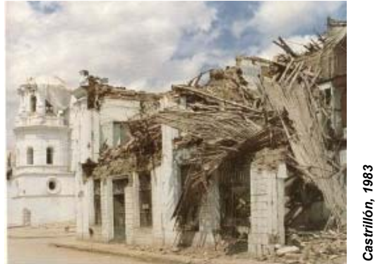
Figura 44. Colapso de cubiertas pesadas en construcciones de adobe, debido al terremoto de Popayán del 31 de marzo de 1983.
