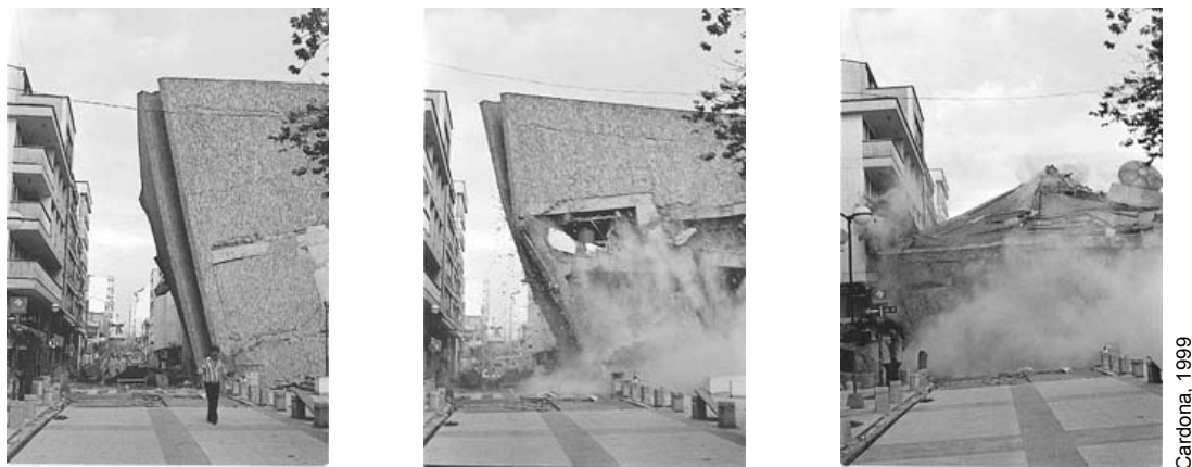
Figura 51. Colapso de un edificio moderna en Armenia, durante la replica de las 5:40 p.m el 25 de enero de 1999.
