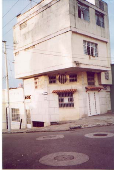
Figura 12. Edificación con irregularidad en altura.
