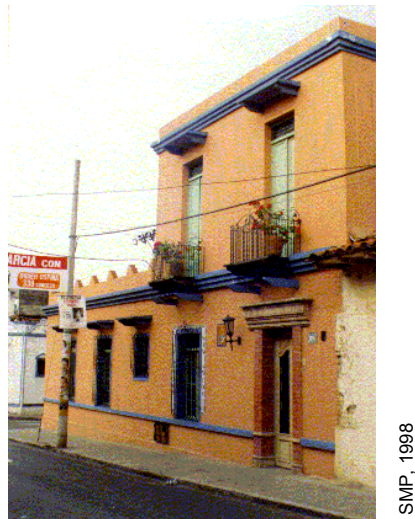
Figura 66. Edificación ecléctica en la zona de estudio.
