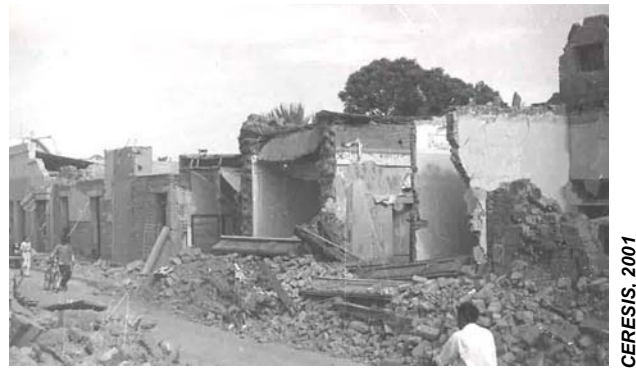
Figura 46. Viviendas destruidas por el terremoto de San Juan, Argentina, en 15 de enero de 1944.
