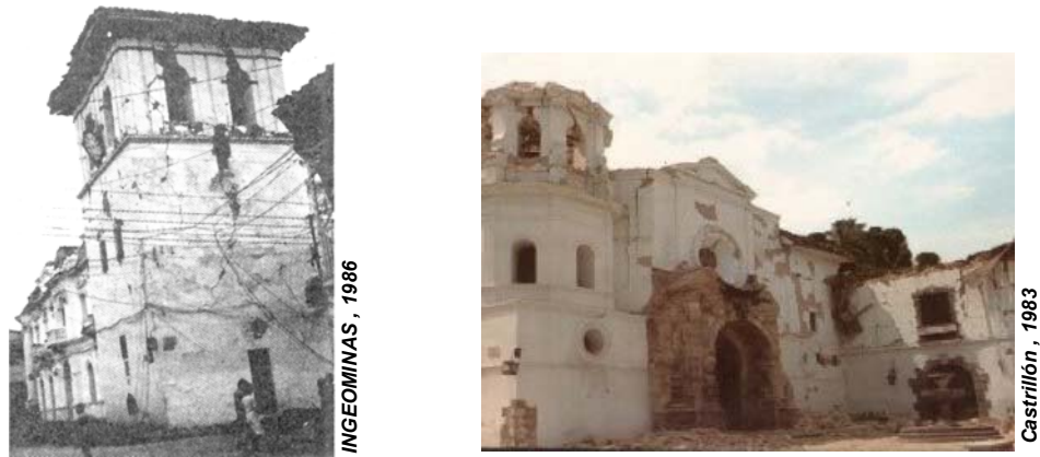
Figura 39. Avería en templos religiosos en Popayán debido al sismo del 31 de marzo de 1983.
