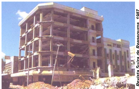
Figura 29. Edificio moderno de estructura aporticada.
