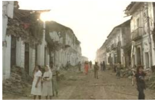
Figura 49. Viviendas de adobe afectadas por el terremoto del 31 de marzo de 1983 en Popayán.
