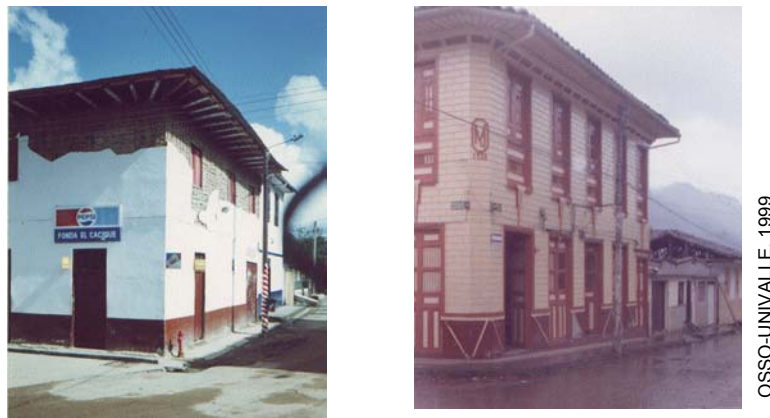
Figura 53. Edificaciones de bahareque “Estilo temblorero” en el Eje Cafetero.
