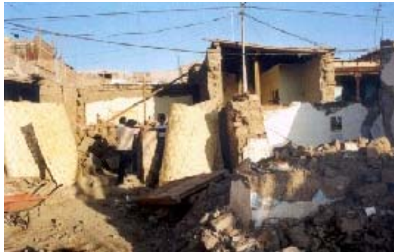
Figura 36. Vivienda de adobe destruida por el terremoto de Arequipa de 2001.
