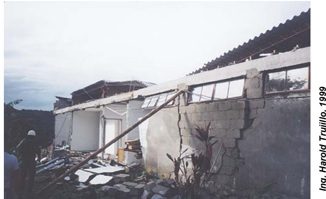
Figura 28. Colapso del hospital del Municipio de Córdoba Quindío, por deficiencias constructivas, terremoto del 25 enero de 1999 en el Eje Cafetero.
