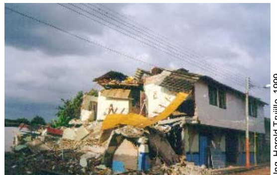
Figura 52. Colapso de una edificación moderna de construcción popular, terremoto del 25 de enero de 1999 en el Eje Cafetero.
