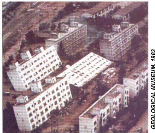
Figura 25. Pérdida de la capacidad portante del suelo por licuación, Nigata (Japón) 1964.
