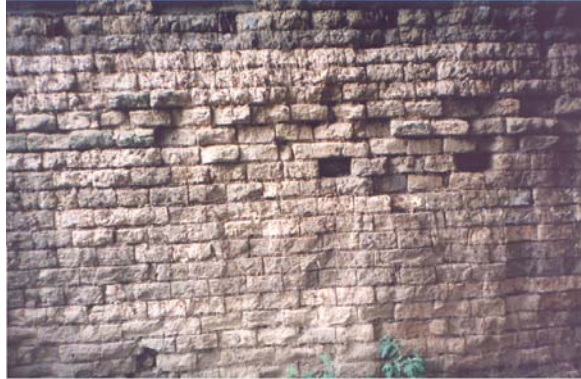
Figura 122. Detalle de un muro de adobe.
