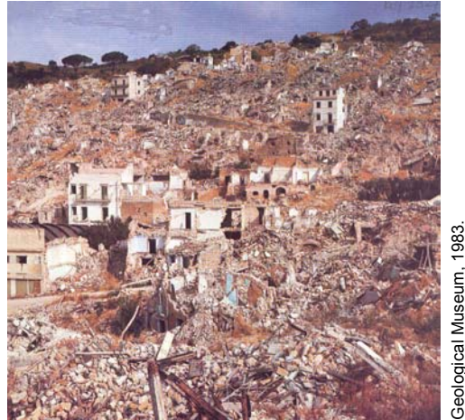
Figura 8. Graves daños en edificaciones construidas en pendiente. terremoto de Iran 1968.
