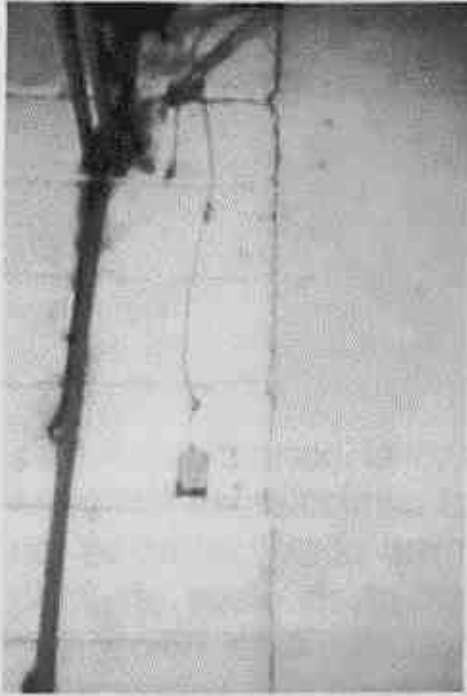
Ausencia de junta constructiva entre la edificación antigua y ampliación adosada.
