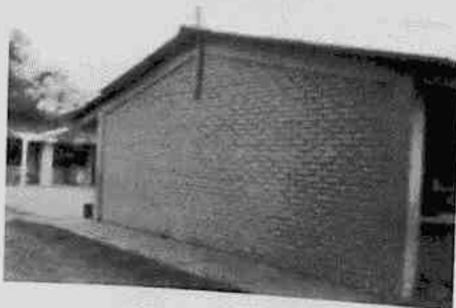
Distancia entre elementos de confinamiento vertical, mayor a la altura de entrepiso.
