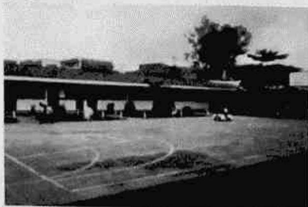
Cubierta pesada, colindancia y características de vanos.
