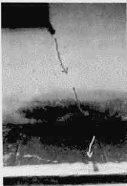
Agrietamiento de antepechos sin confinamiento en zonas con evidencias de asentamientos del terreno.
