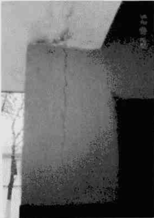
Fallas en los muros estructurales por asentamientos diferenciales de la edificación. Deterioro de cielorasos.
