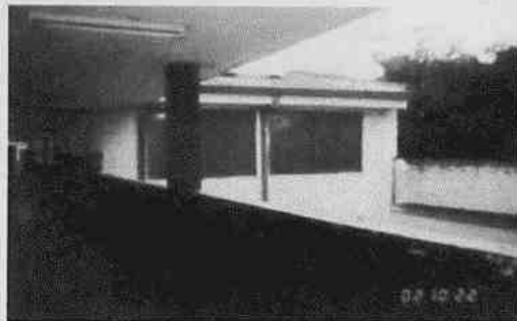
Columnas de apoyo de la losa de entepiso solo en corredores.
