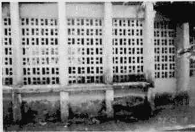
Vanos a todo lo largo de los muros en una dirección.
