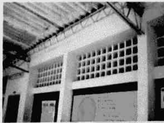
Aberturas a todo lo largo de muros en una dirección.
