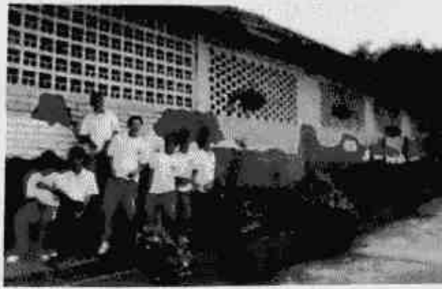
Sistema estructural mampostería sin confinar. Muros estructurales en una dirección y grandes aberturas en la otra. Ausencia de viga corona.
