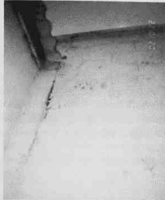
Ausencia de junta constructiva entre la edificación antigua y ampliación adosada.
