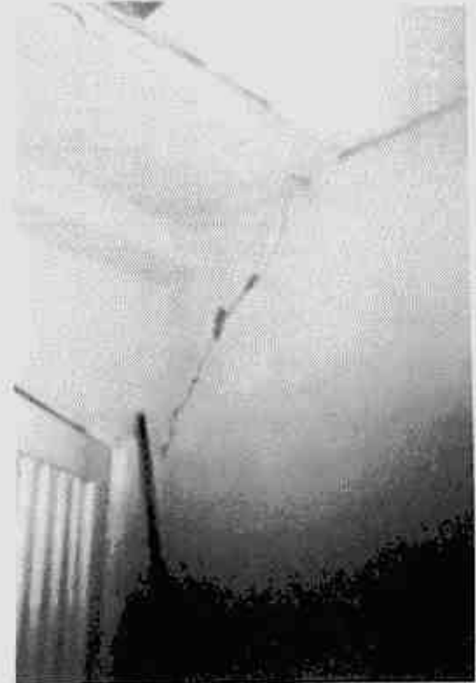
Fallas en los muros estructurales por asentamientos diferenciales de la edificación. Deterioro de cielorasos.
