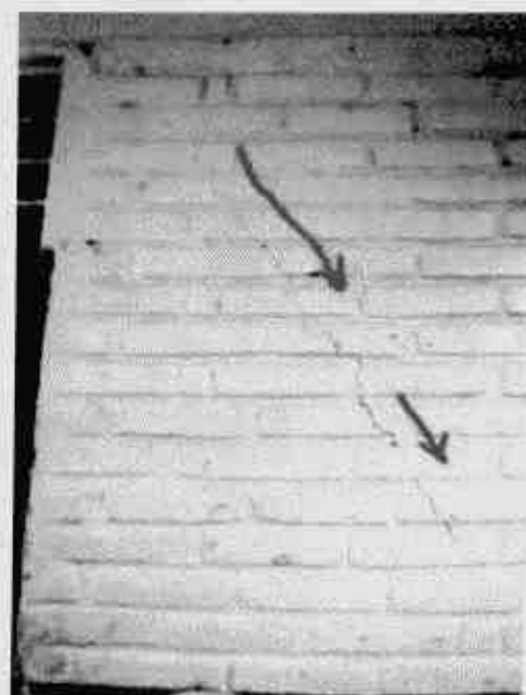
Fisuramiento de elementos estructurales (viguetas, columnetas, muros, y cerramiento) y no estructurales.
