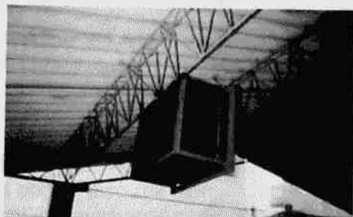
Elementos no estructurales sueltos (Baffles, culatas). Ausencia de viga corona.
