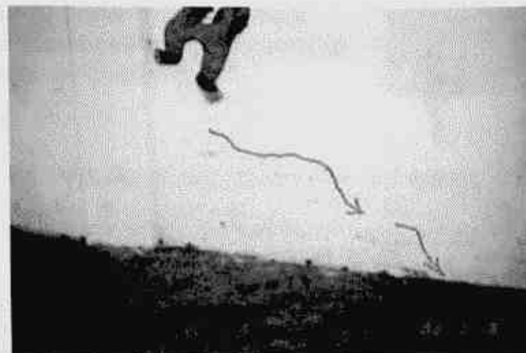
Agrietamiento de antepechos sin confinamiento en zonas con evidencias de asentamientos del terreno.
