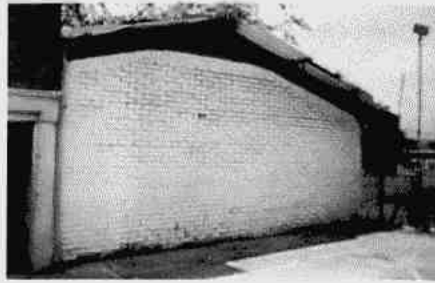
Sistema estructural mampostería sin confinar. Muros estructurales en una dirección y grandes aberturas en la otra. Ausencia de viga corona.
