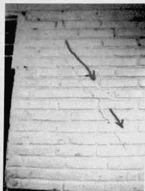
Fisuramiento de elementos estructurales (viguetas, columnetas, muros, y cerramiento) y no estructurales.
