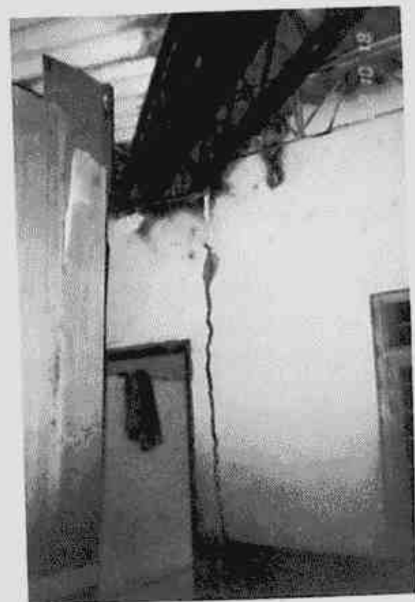
Viga metálica que da soporte a la cubierta, apoyada directamente sobre un muro sin confinar (en el acceso al baño de los niños) amarrada inadecuadamente al resto de elementos de la estructura de cubierta.
