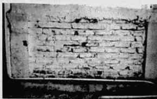
Fisuramiento de elementos estructurales (viguetas, columnetas, muros, y cerramiento) y no estructurales.
