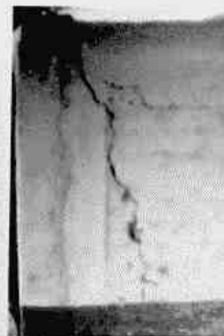
Falla en un muro por asentamientos del terreno y mala calidad constructiva.
