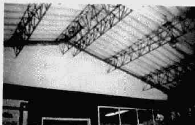
Elementos no estructurales sueltos (Baffles, culatas). Ausencia de viga corona.
