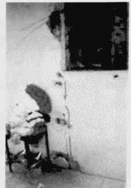
Agrietamiento de antepechos sin confinamiento en zonas con evidencias de asentamientos del terreno.
