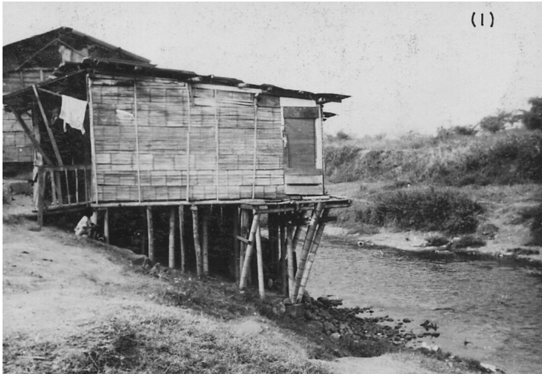
Figura 22. Vivienda en la ribera del río Cali en el barrio Fátima, década 1960. Éste y el barrio Bolivariano (Figura 21) se ubicaron en la zona dejada por el antiguo cauce del río Cali, antes de la canalización de este sector en 1955. Ambos barrios fueron clasificados por Planeación Municipal como áreas de erradicación por su localización en zonas inundables y ausencia de servicios públicos. (Planeación Municipal, 1964).
