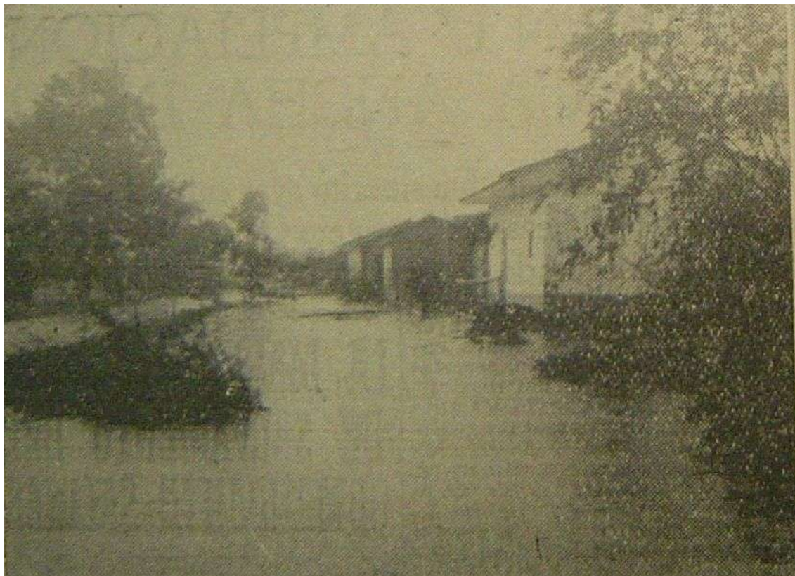
Figura 24. Imagen de la Inundación de 1938. “Los Estragos del invierno en el Valle: ... Las casas adyacentes a la carretera de El Guabito a Juanchito, en peligro de ser destruidas por las corrientes del río Cauca...” (Fuente: Relator, Diciembre 15 de 1938 P.2).
